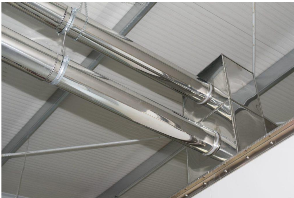
Figura 28 - Sistem admisie-evacuare aer uscator
