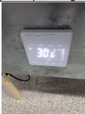
Valoarea temperaturii setate pe afisorul blocului electronic al ventiloconvectorului
