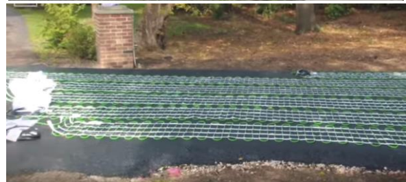
Fig. 9. Eliminarea zăpezii prin topirea cu sistem electric
