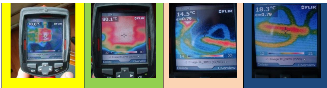
Fig. 3 – Analiză termografică comparativă la pompe și cilindri hidraulici cu și fără uzură
