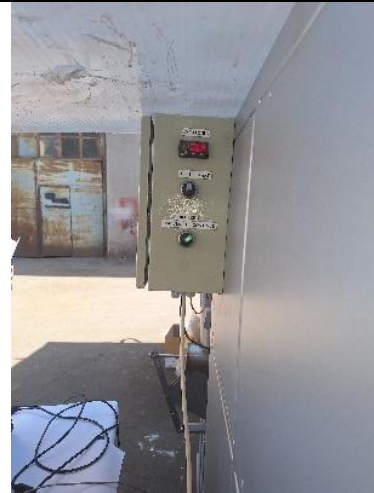
Fig. 4. Modul electronic de monitorizare și control parametri proces de deshidratare
