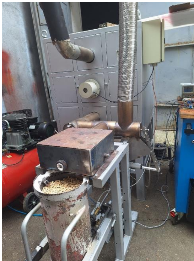
Fig. 1 Modul termic cu reactor gazeificare TLUD, realizare fizica
