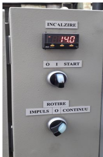
Fig. 28 Tablou electric cu afisor pentru vizualizarea temperaturii din incinta de uscare (sus), comanda ventilatorului recirculare agent uscare (jos)
