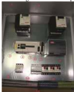
Fig. 5 Sistemul de monitorizare si control din componenta standului de probare
